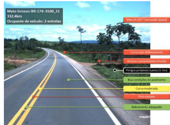
Figura 2 – Exemplo de rodovia de 2 estrelas
