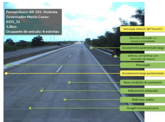
Figura 4 – Exemplo de rodovia de 4 estrelas
