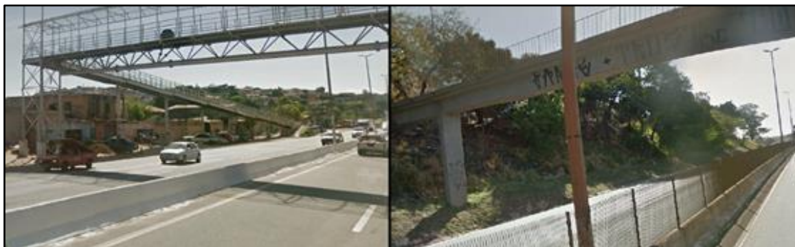
Figura 2: Trecho 1 e Trecho 2, respectivamente
